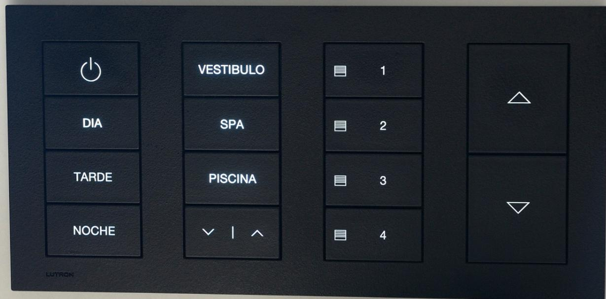
初めて使用する方でも簡単に部屋の照明や電動カーテン/シェードの操作ができるよう配慮されたPalladiom（パラディウム）キーパッドのアイコン
